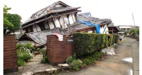
平成 28 年熊本地震での建物被害
