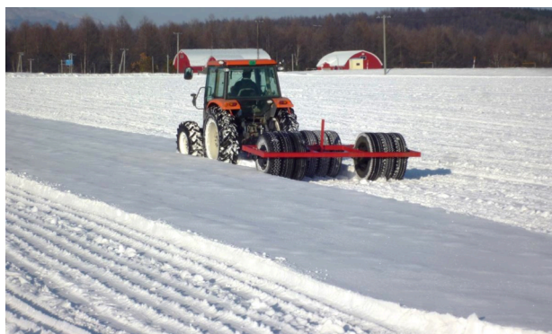
写真 III-3 タイヤローラを用いた雪踏み実施状況
