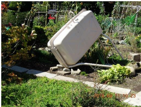
灯油タンクの倒れ
