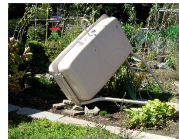
写真7-2 地震による灯油タンク転倒被害
