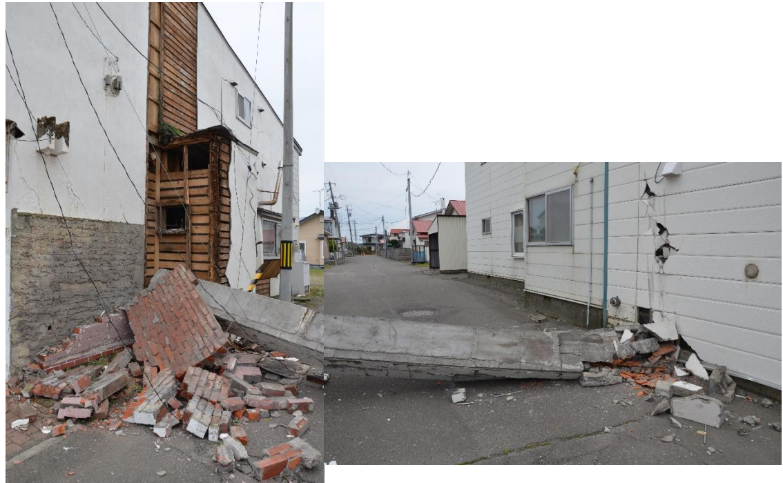
集合煙突の倒壊
