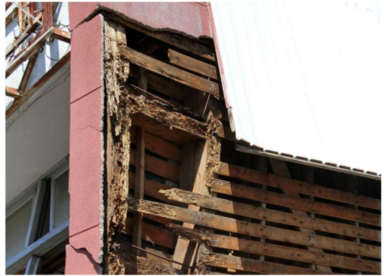
写真1 柱材の腐朽
