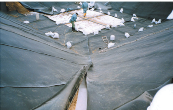
しゃ水シートの敷設状況
