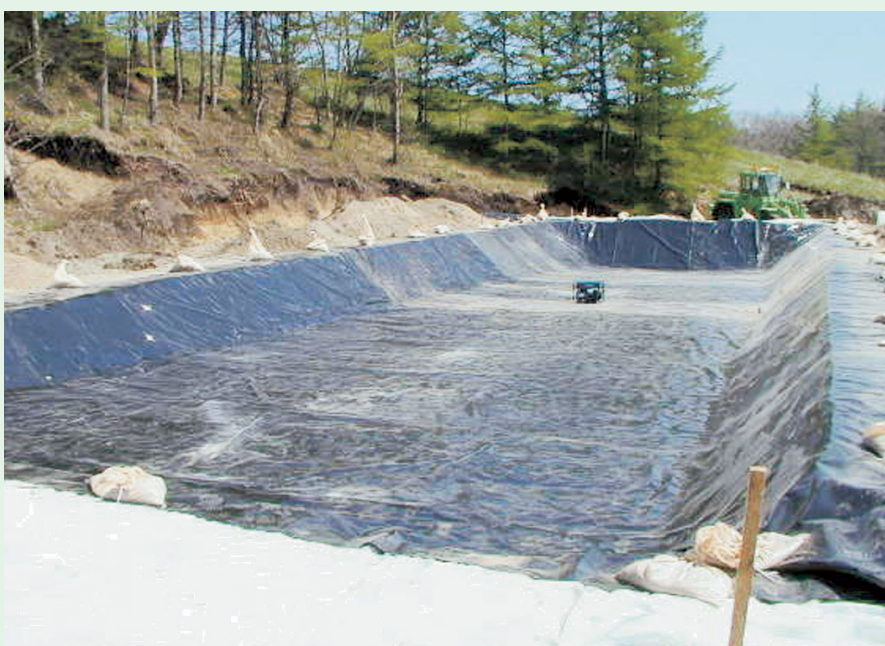
底部シートの設置完了
