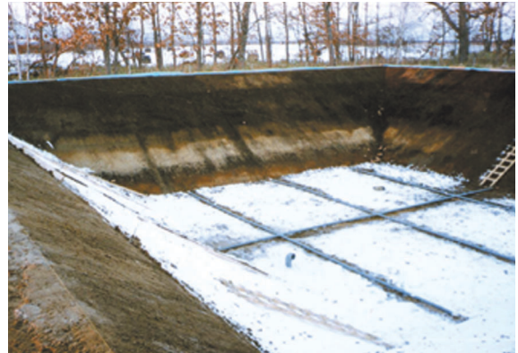
ガス抜き配管の設置状況
