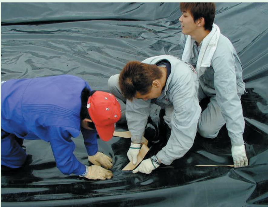
底部シートの子チレンテープによる設置作業
