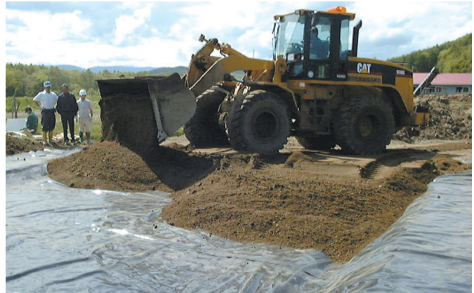
土の搬入作業
