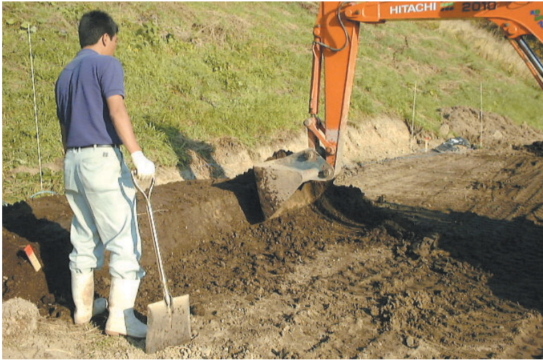
盛土の成形作業
