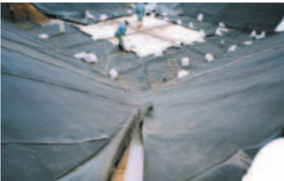
しゃ水シートの敷設状況
