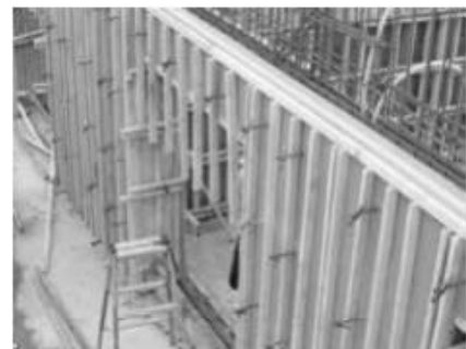
外断熱用外装パネルの施工の様子
