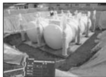
処理装置の設置工事状況
