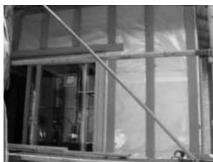
胴縁としての施工例
