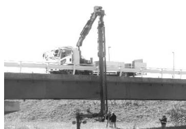
「橋竜」2号機による点検
