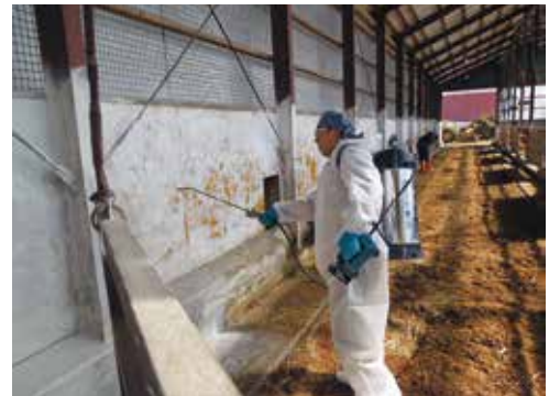
ポータブルの吹付機器での塗布試験
