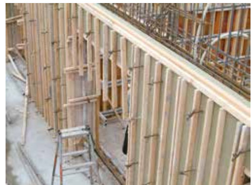
外断熱用外装パネルの施工の様子
