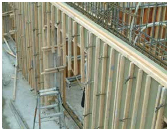
外断熱用外装パネルの施工の様子
