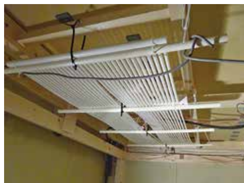
天井空間埋設前の放射パネル
