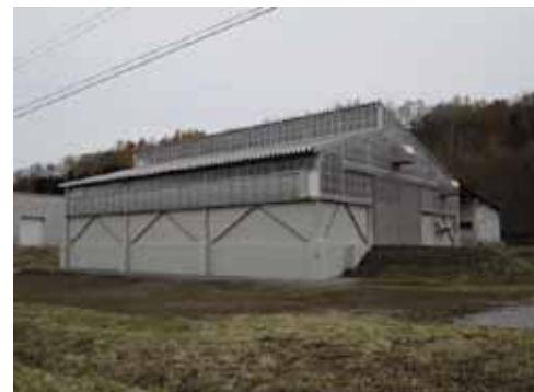
生ゴミ堆肥化施設
