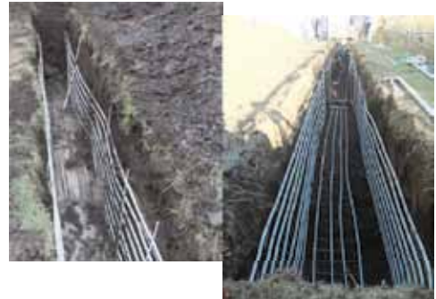
樹脂製柵状地中熱交換器の外観
