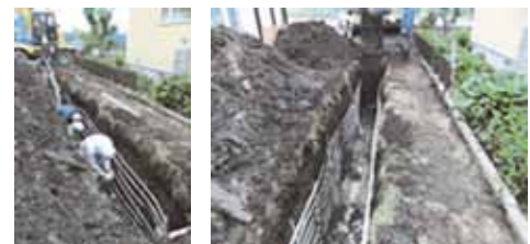
柵状地中熱交換器の施工状況
