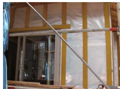
胴縁としての施工例
