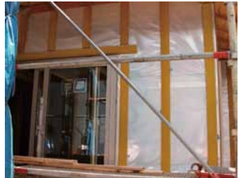
胴縁としての施工例
