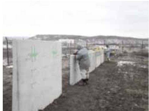
火山灰を利用したコンクリート
