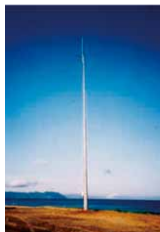
風況精査の様子
