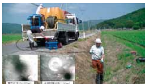
検査・洗浄試験の様子（宮城県／石巻）
