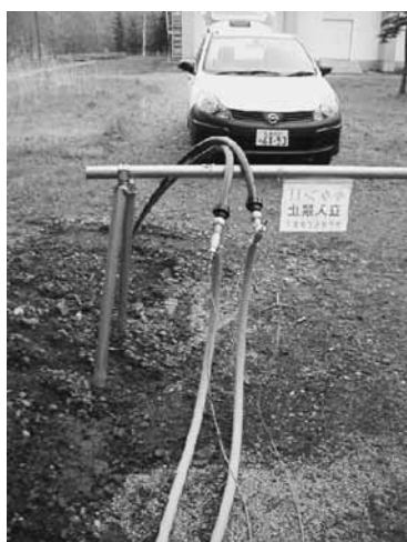
採熱孔への配管
