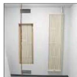
埋め込み形(左)及び露出形のプラスチック製ラジエータ
