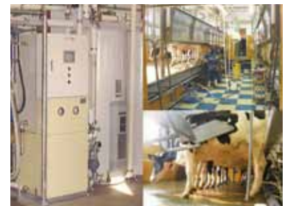
写真③ 牛乳熱利用ヒートポンプ給湯 システムの開発
