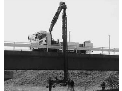
写真① 橋梁点検ロボット車輛
