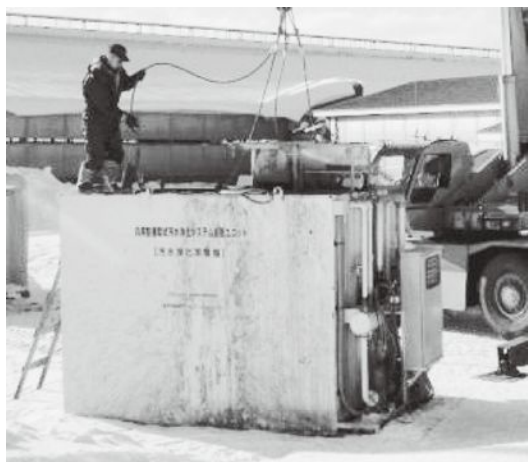
試験装置の現場設置風景
