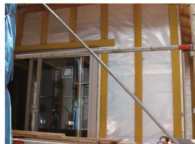
胴縁としての施工例
