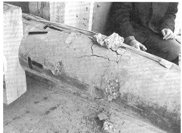
写真3 PCポールの曲げ破壊(Case II : CFRP)
