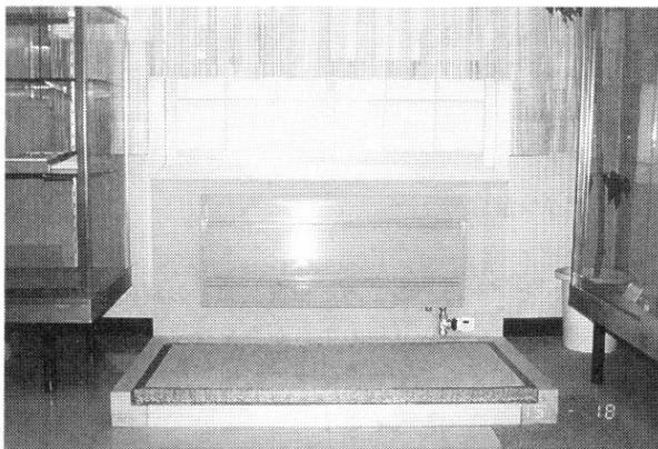
写真1 和室用温水パネルヒーター（S）の概観
