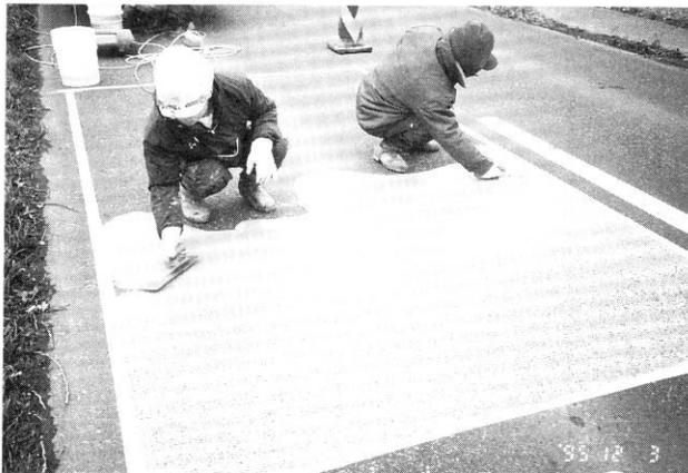
写真1 凍結抑制舗装の施工状況
