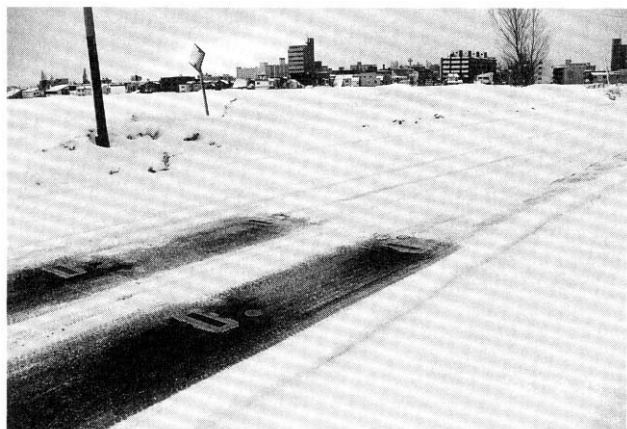
写真 4.6 しみ出しノズル
