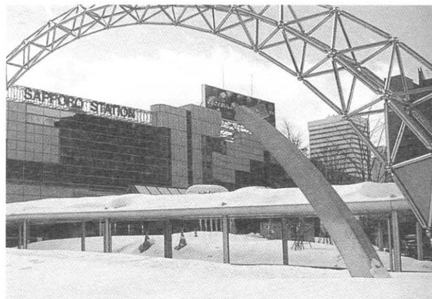
図-3 着雪により顕在化された歩行者シェルター
