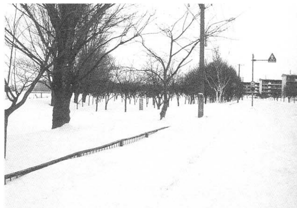
図-10 積雪により歩車境界の判別が困難になっている例
