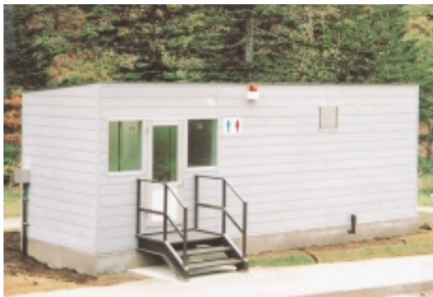
図4 実規模システム事例（ユニットタイプ）
