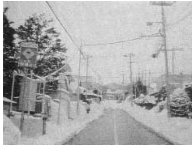
図8 凍結検知装置設置風景
