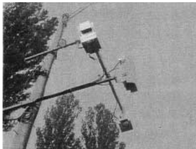
図3 構内設置赤外カメラと投光器
