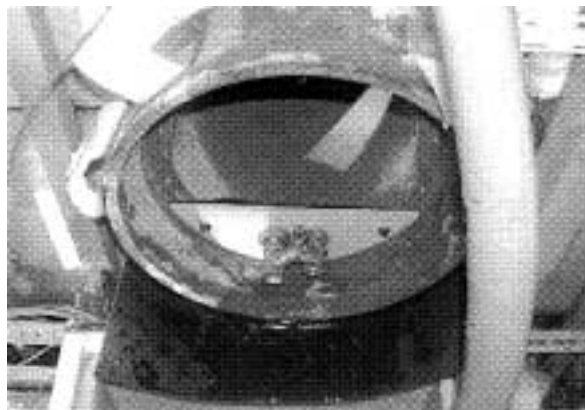
図3.2 堰（水位1/4）の設置状況
