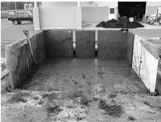
図14 パネルを利用した簡易堆肥盤
