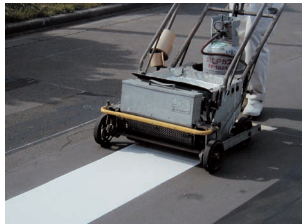
図5 スリット式施工機
