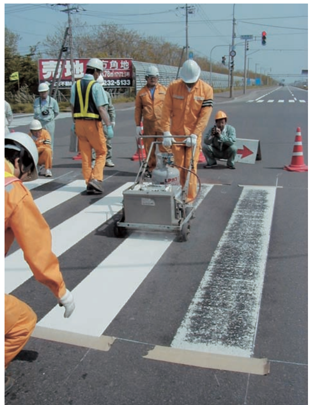
図13 横断歩道施工状況
