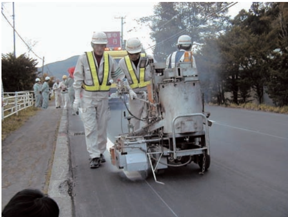
図6 溶融噴射式施工機
