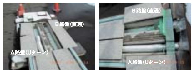
(a)路盤後方部 (b)路盤前方部
