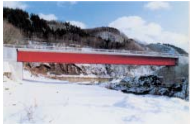
図3 道路橋への防食溶射（北斗市）
