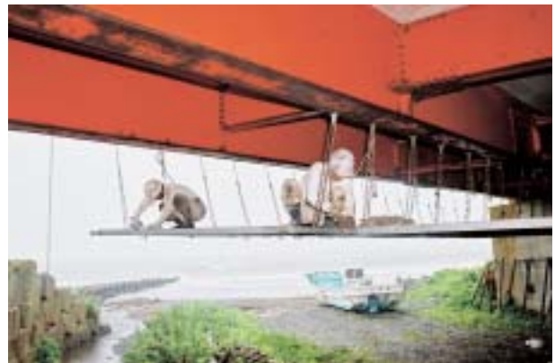
図11 足場の架設作業
