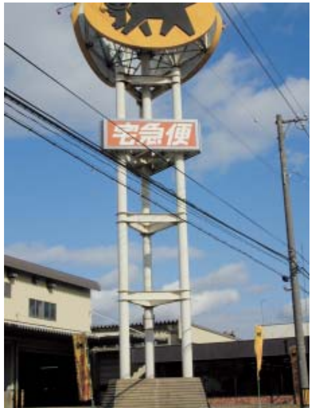
図4 広告塔への防食溶射（苫小牧市）
