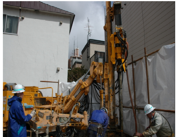
写真2 ボーリング作業
