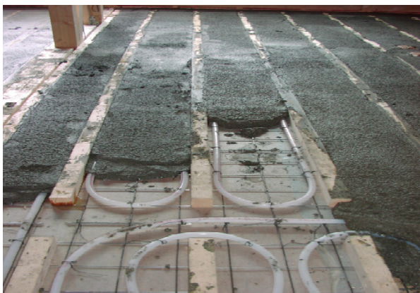
写真3 床暖房施工状況
