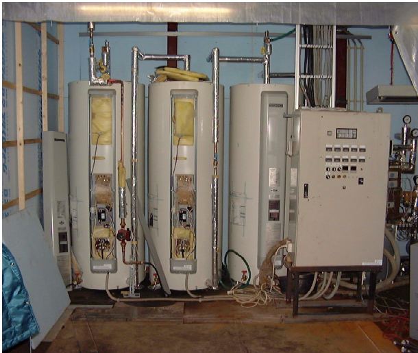
写真13 貯湯槽
