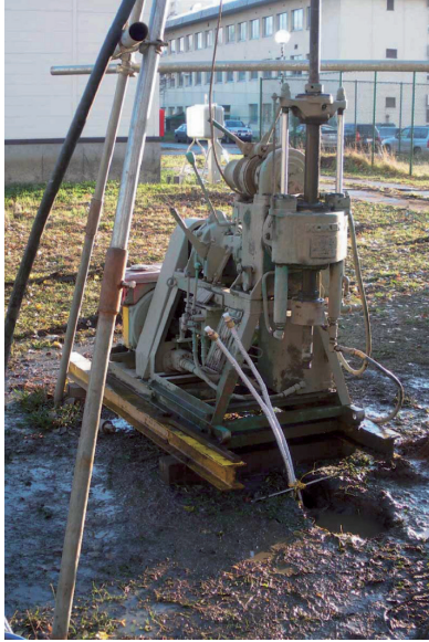
図6 ボーリング装置の外観
