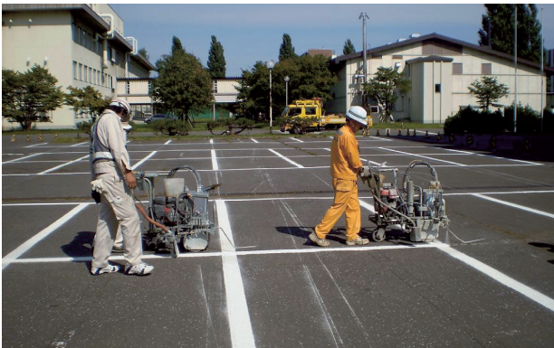
図3 区画線施工状況
