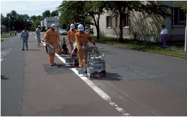
図1 センターライン施工状況
