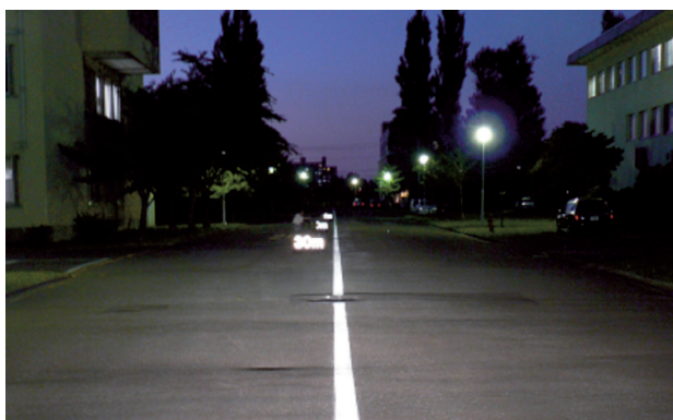
図12 ホタテ材センターライン（施工直後）
