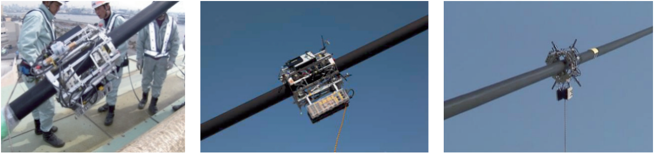
図21 実証大型機による実橋試験の様子
