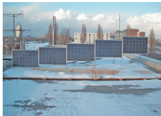
図6 平成23年度試験モデル設置の様子
