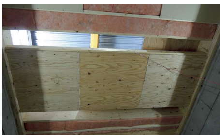
b) 天井板の取り付け
