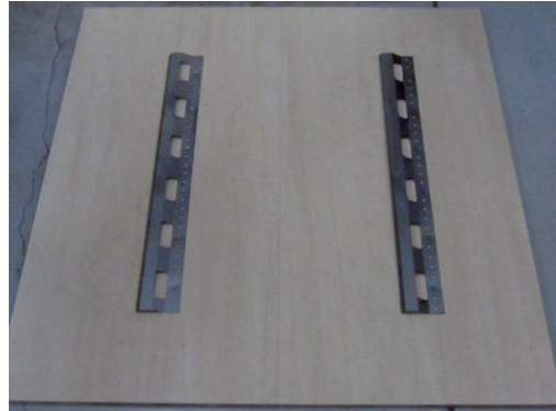
a) 防振鋼板の設置
