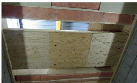
b) 天井板の取り付け
