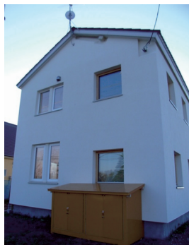
図13 採熱実験を行った実験住宅の外観
