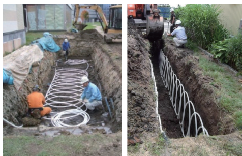
図1 「Slinky」方式の熱交換器の外観
