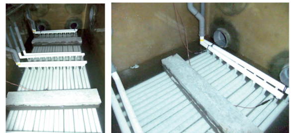
図17 排湯槽周辺及び排湯槽内の外観 (C施設)
