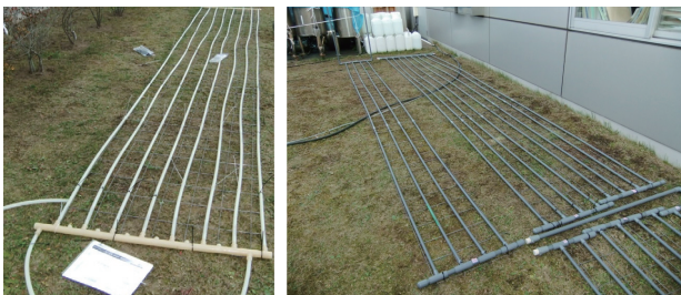
図5 作製した樹脂製柵状地中熱交換器の外観 (左:耐熱ポリエチレン管縦柵状, 右:塩化ビニル管横, 縦柵状)
