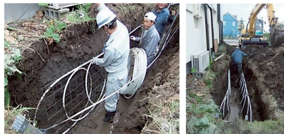
図16 Slinky熱交換器の設置、埋設状況
