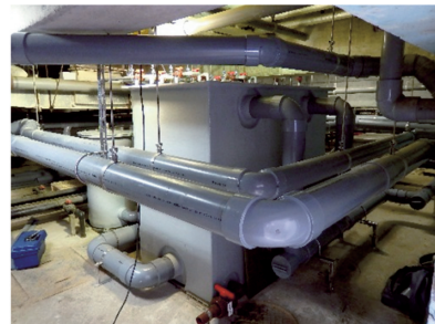
図16 排湯槽周辺及び排湯槽内の外観（A施設）
