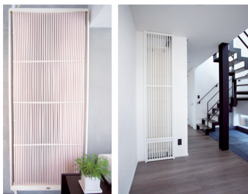
図1 樹脂製柵状ラジエータの外観
