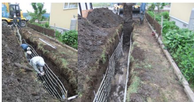
柵状地中熱交換器の施工状況
