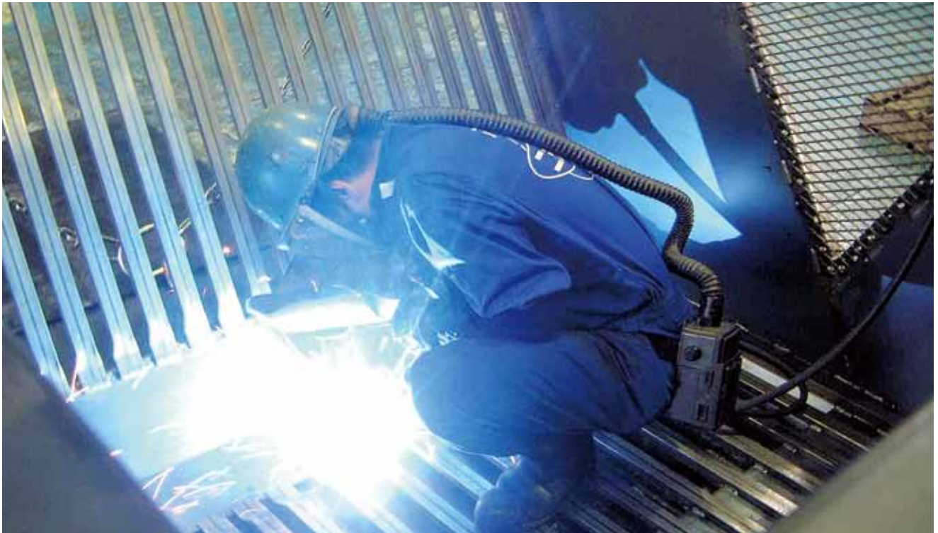
溶接作業の様子
