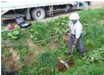
検査洗浄作業
