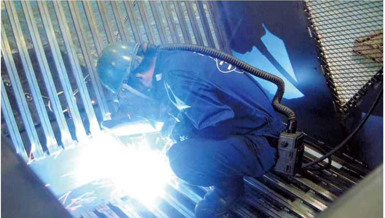
溶接作業の様子
