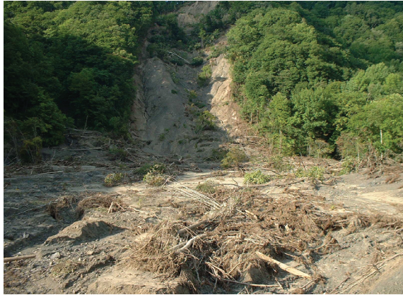
写真-11 崩壊地からの流木が河川敷に散在
