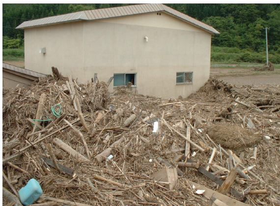
写真－7 家に押し付けられた流木群
