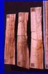
腐朽は垂直方向にも進む
