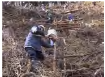
木杭に横木を渡して棚を作り、残材を集積します。
