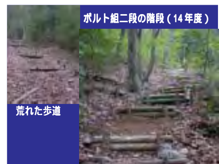
図4 階段補修工事の様子
