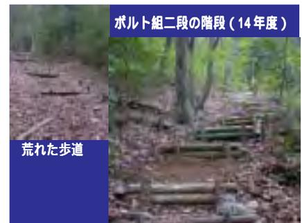
図4 階段補修工事の様子
