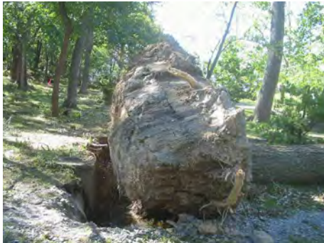
地中の土管によって根系の発達が阻害され、根返りした
