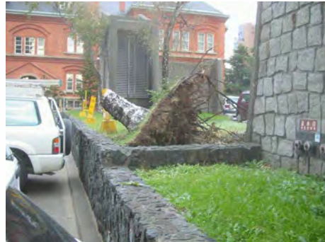
狭小な石張りの植樹升により、根系の発達が阻害され、根返りした
