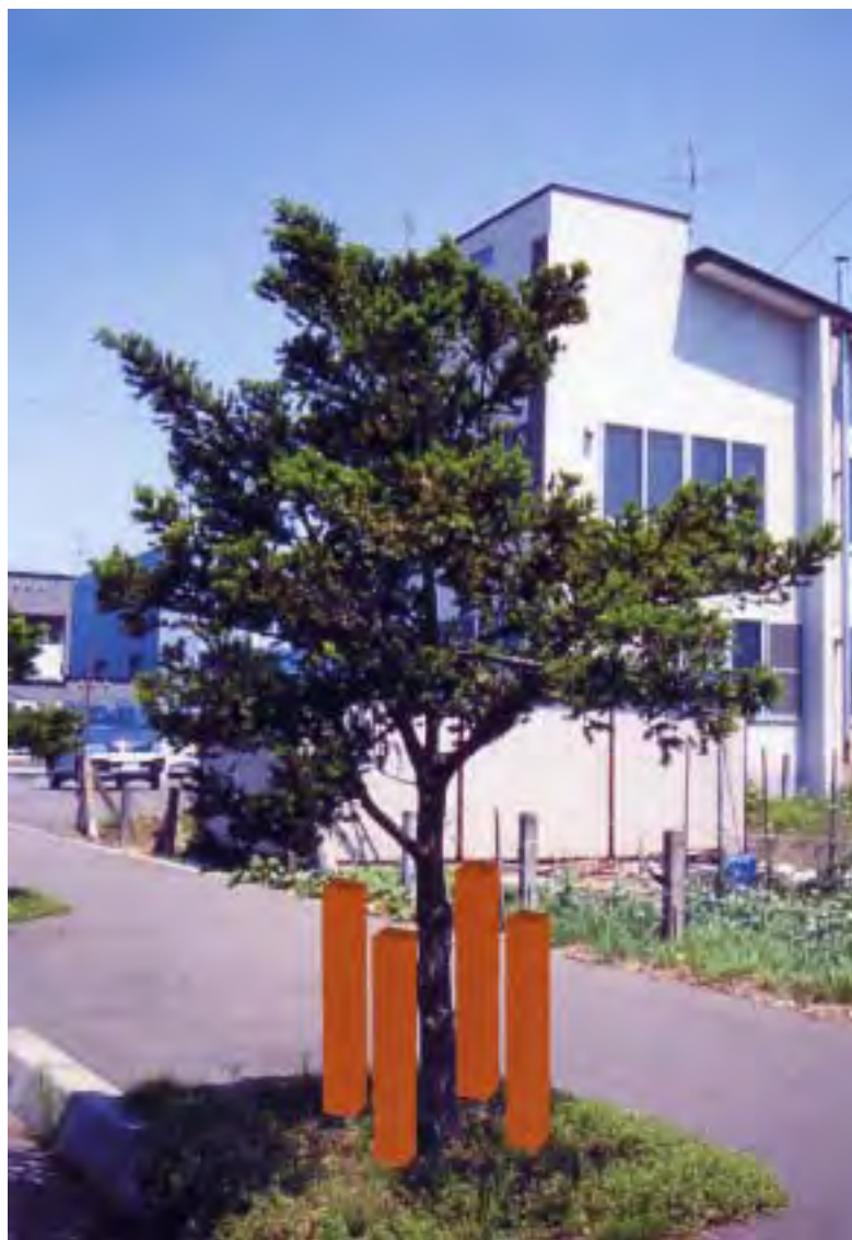
写真 街路樹保護のための保護杭の設置
