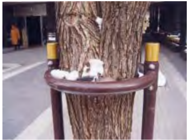
写真-4 幹が太くなるとツリーガードも大きなものが必要になる
