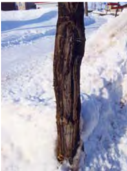
写真-3 大きな傷口から幹の腐れが広がる
