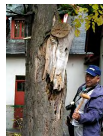
ヤマグワ(腐朽が進んでいるが様子を見る)
